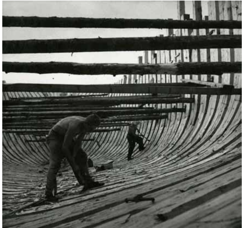
Kuvassa viimeistellään puurunkoisen kuunarin kaaria Raumalla vuonna 1951. (Suomen merimuseon kuvakokoelma)
