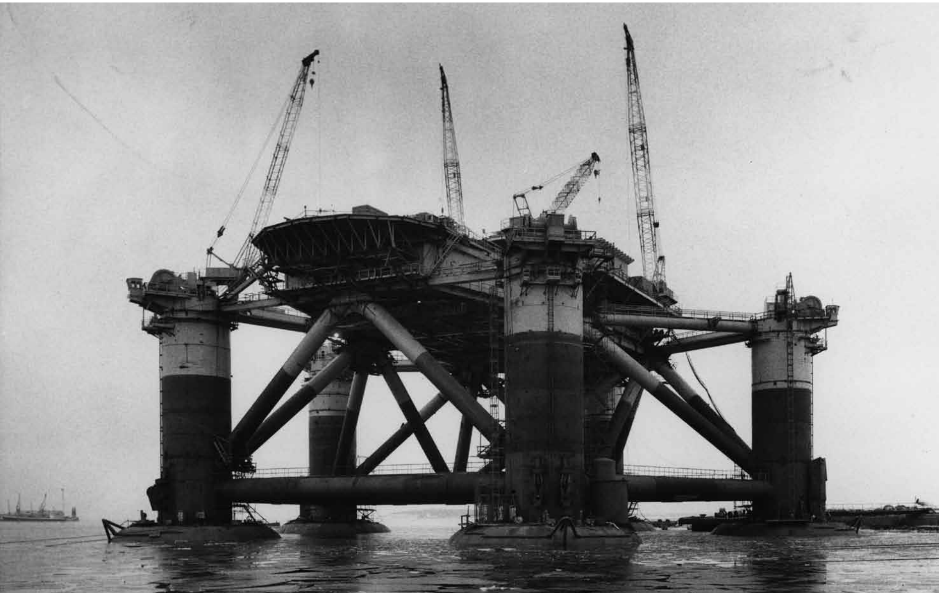
Rauma-Repolan rakenteilla oleva öljynporauslautta Pentagone 12.3.1974. Mäntyluoto, Pori. [Sven Raita, Satakunnan museo]
