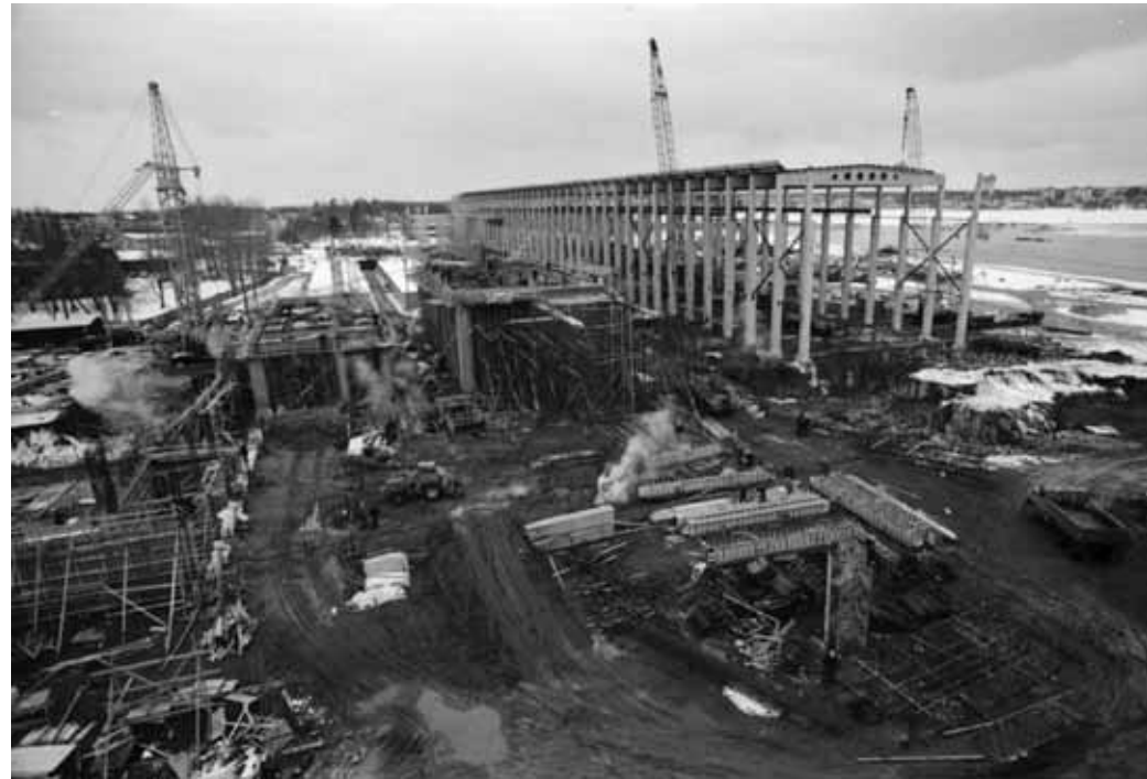
Rakenteilla oleva Vuosaaren telakka loskaisena kevätpäivänä vuonna 1974. (Simo Rista, Helsingin kaupunginmuseo)
